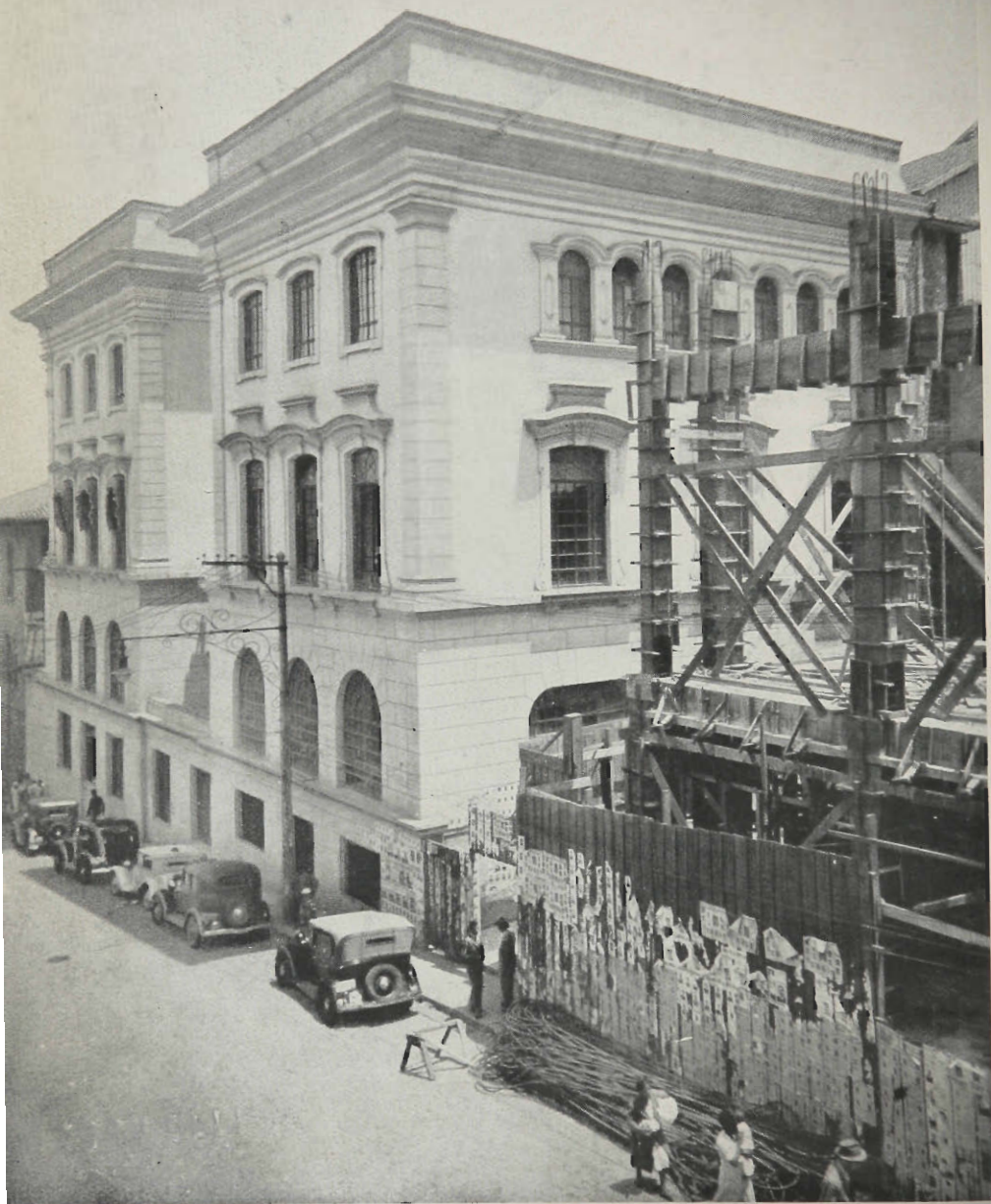
Fig. 20 — Fachada do novo edificio, executada na rua Riachuelo,
