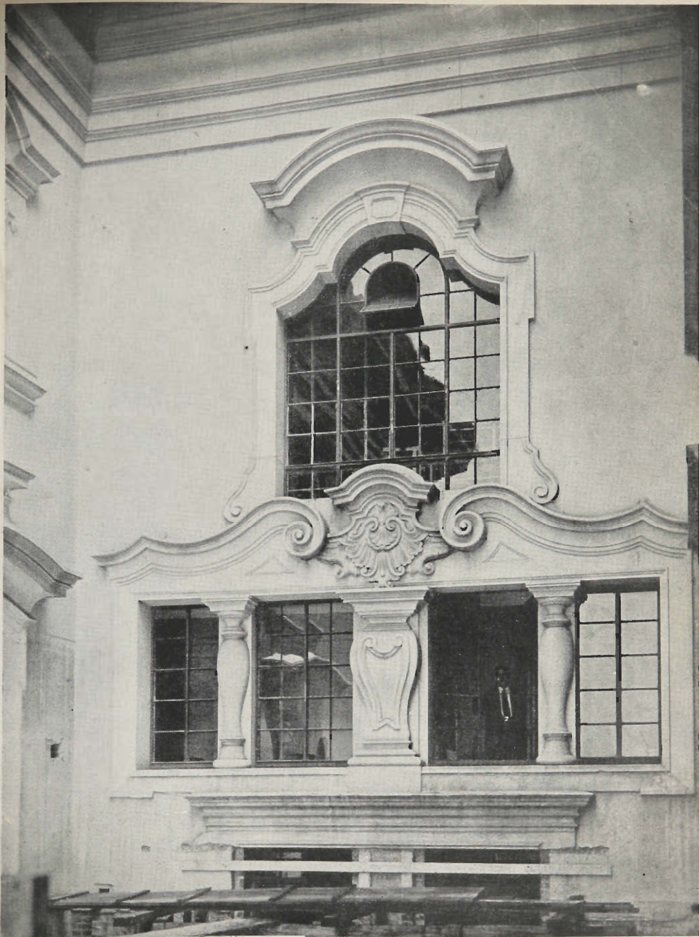
Fig. 21 — Detalhe dos pateos nos fundos.
