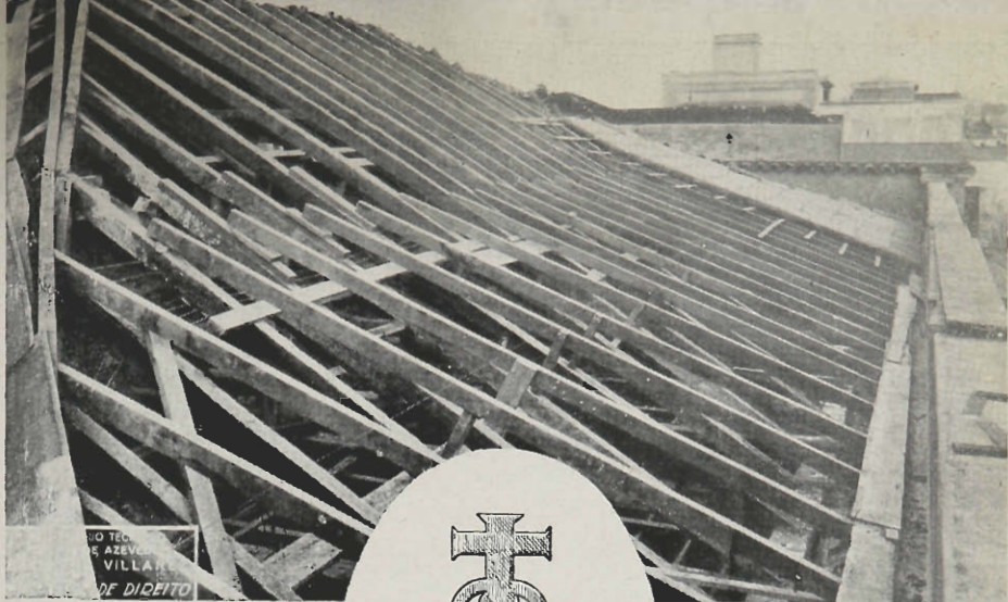
Fig. 5 — Armadura do antigo telhado.
